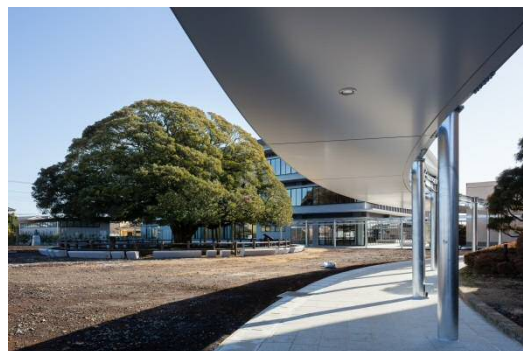
屋根付の通路 (茨城県城里町庁舎)
