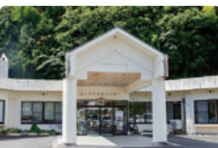
五ヶ瀬町福祉センター
