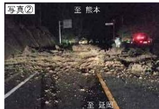
▲崩土による通行止め状況 (H28.6.21) (国道218号 五ヶ瀬町役場前)
