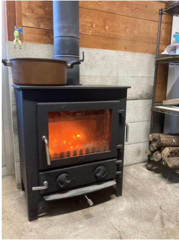
薪ストーブの設置
