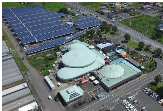
太陽光パネル（下部：駐車場）
