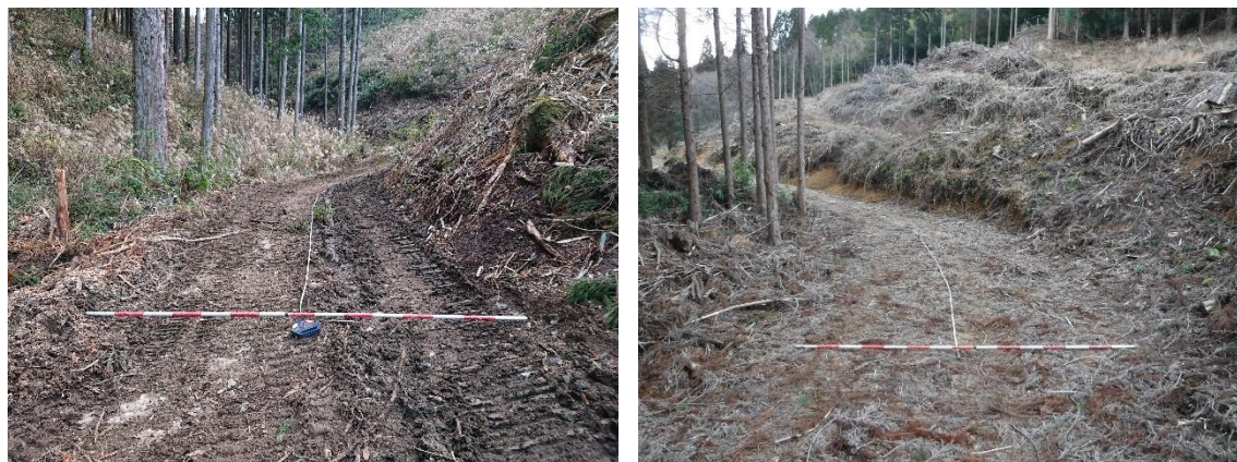
作業道開設状況
