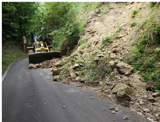
崩土除去作業状況
