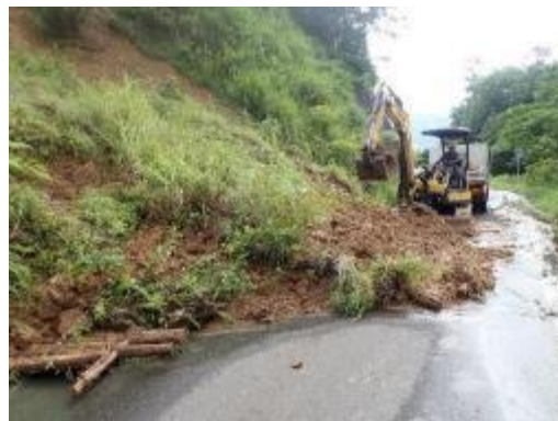
崩土除去作業
