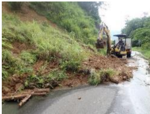
崩土除去作業
