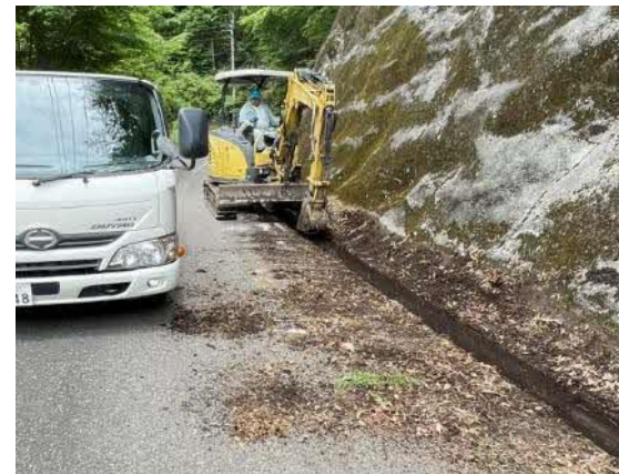
側溝土砂除去状況
