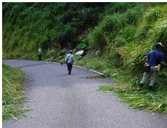
除草作業状況
