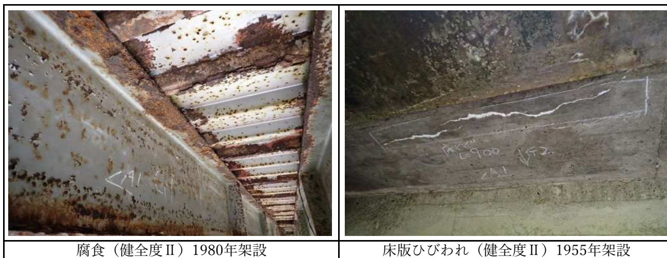
図 6 損傷状況
