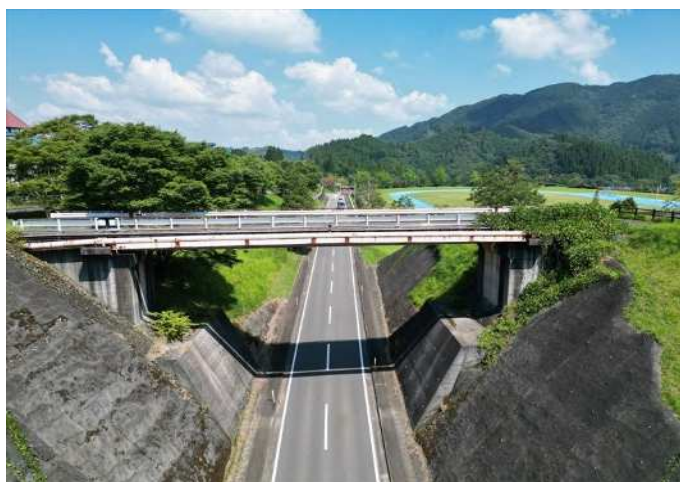
図 10 道路を跨ぐ橋梁の例（五ヶ瀬町管理 広木野陸橋）
