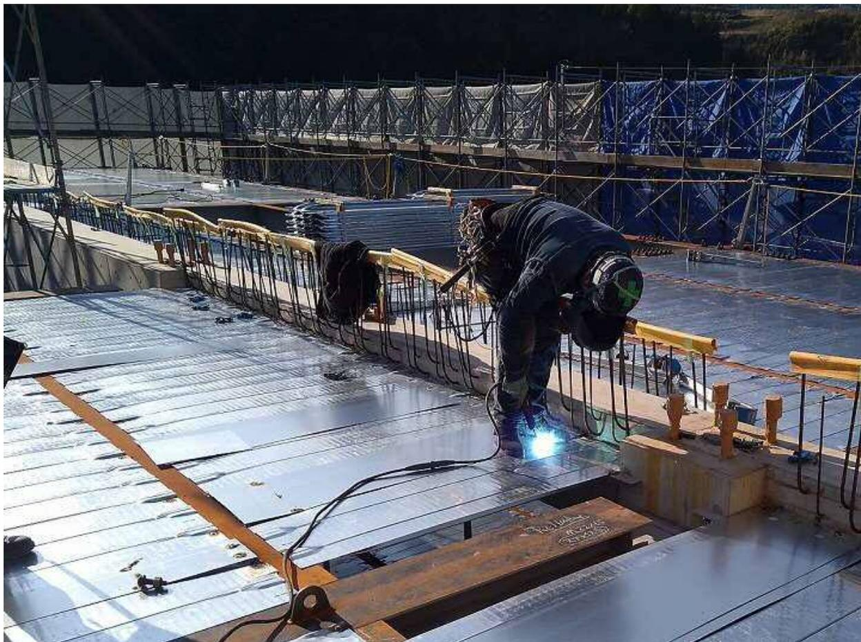
12月23日 3階床のデッキプレート溶接作業
