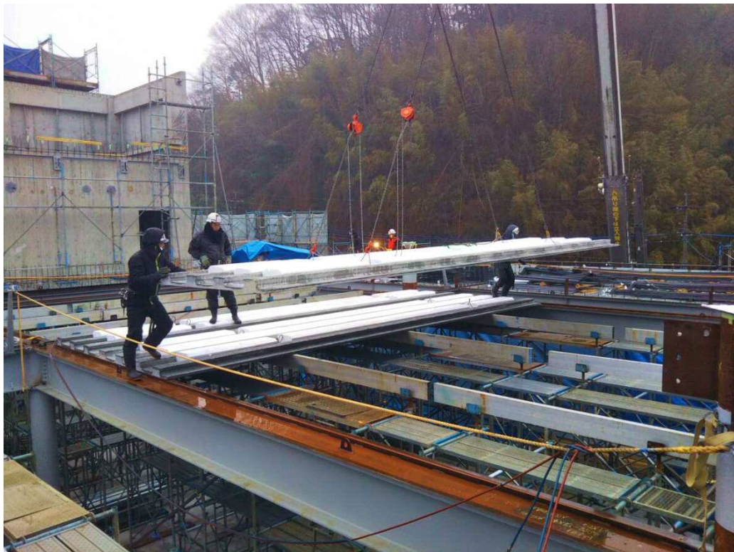
1月23日 3階床のPC版据付作業(2階執務室の天井部分)
