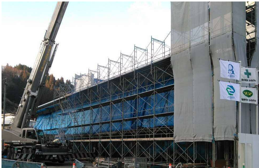
1月21日 コンクリート打設後の採暖養生(ブルーシート部分) (ブルーシートで建物全体を覆い、ジェットヒーターで暖めながら養生)
