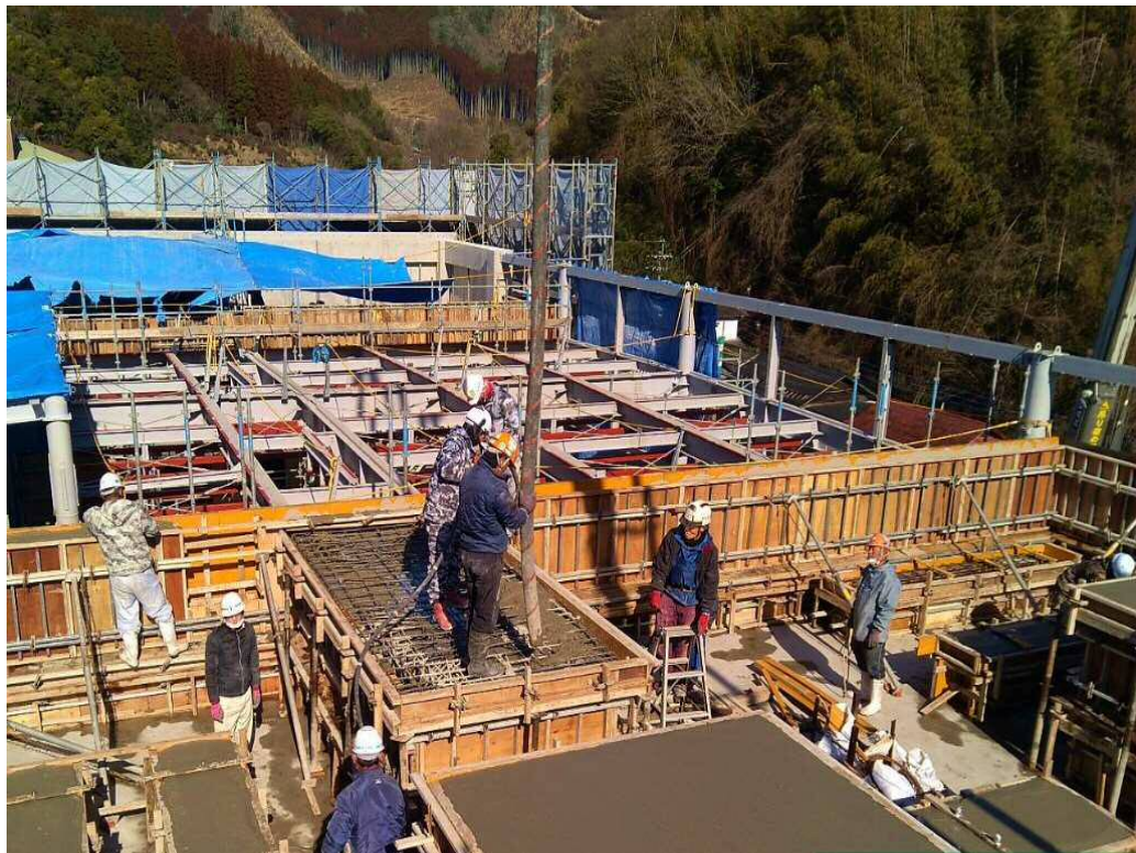
2月17日 屋上コンクリート打設 (機械の基礎や配管が集まる部屋をコンクリートで打設)
