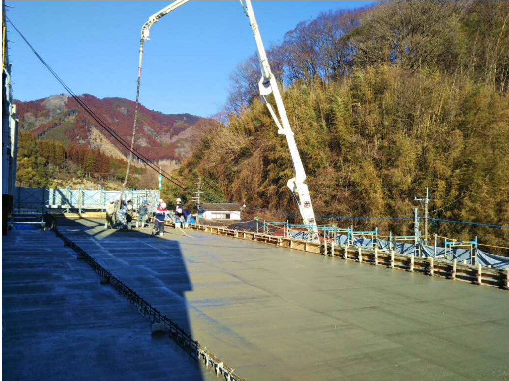
2月5日 2階テラス部分のコンクリート打設状況
