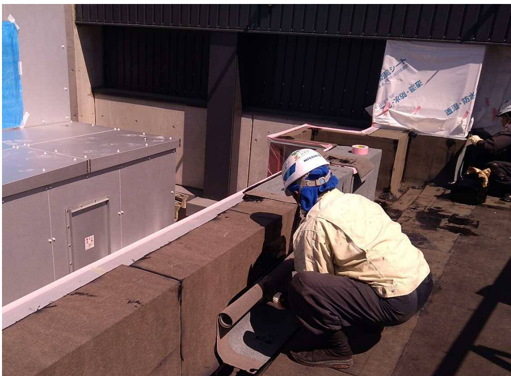
4月26日 屋上防水・・・防水層を何層も重ね、入念に止水を施します
