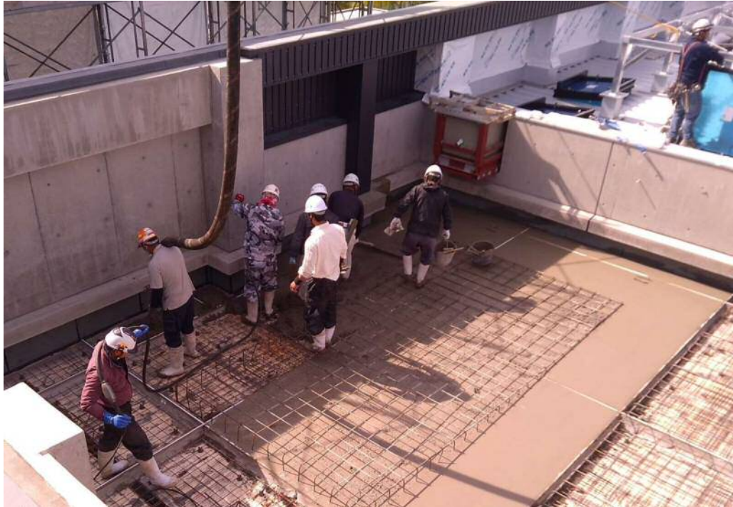
4月15日 屋上コンクリート打設・・・防水工事完了後の保護コンクリート打設状況
