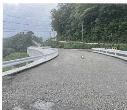
改良が進む竹田五ヶ瀬線（土生工区）
