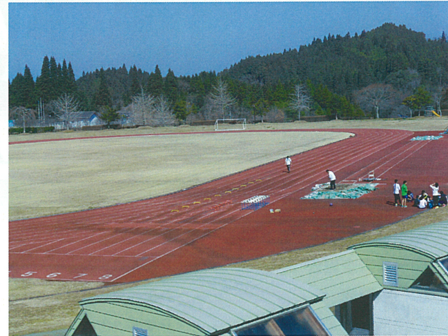
Gパーク陸上競技場トラック全面改修
