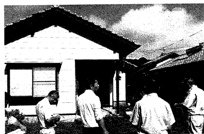
改修された教職員住宅（あけぼの）
