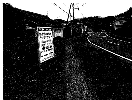
宮野原水道管工事
