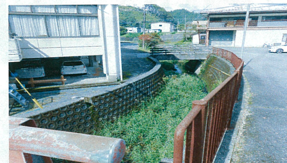
立壁暗渠工事
