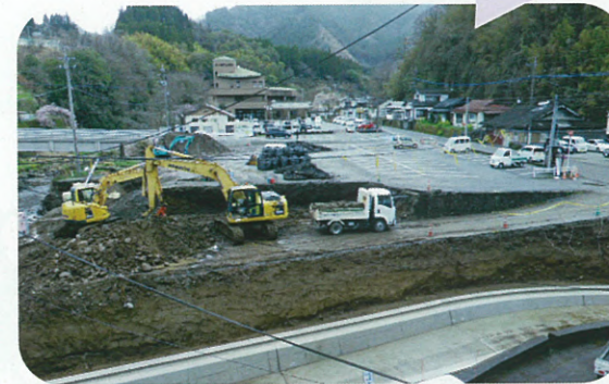
新庁舎建設予定地
