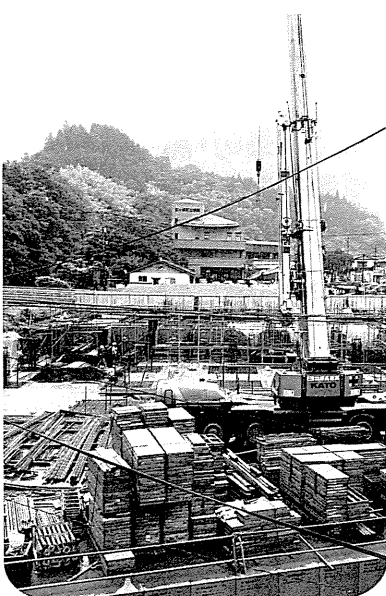
新庁舎建設状況
