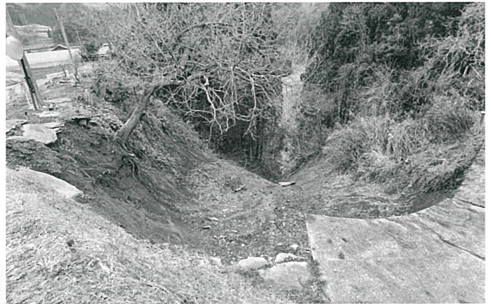
鞍岡地区災害箇所
