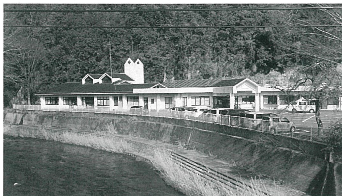
福祉センターの屋根改修工事
