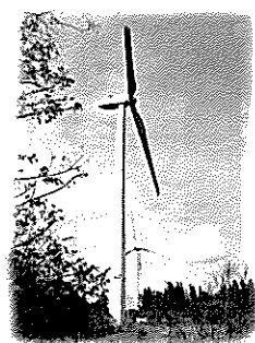
風力発電施設
