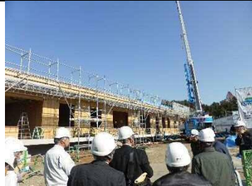
(パネル工法現場)
