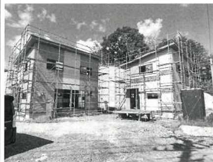
広木野に建設中の住宅
