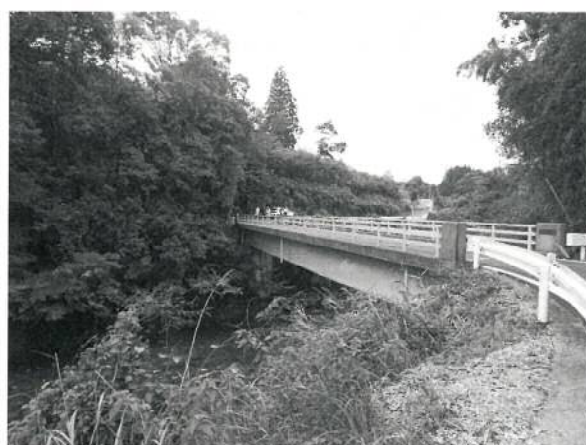
道路メンテナンス事業橋梁補修工事 (坂狩・荒谷線 荒谷橋)
