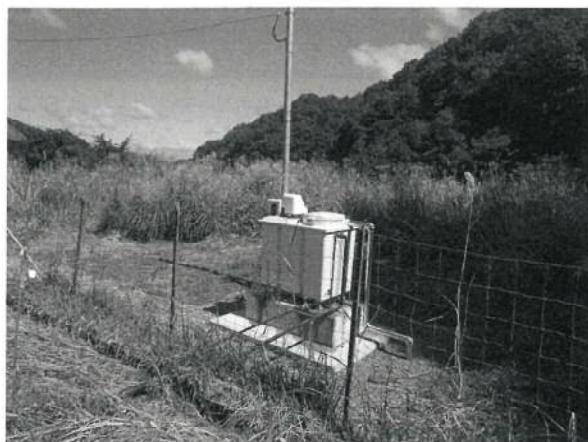
県単独土地改良事業 魅力あるふるさと環境づくり事業 (大平地区営農飲雑用水施設整備)
