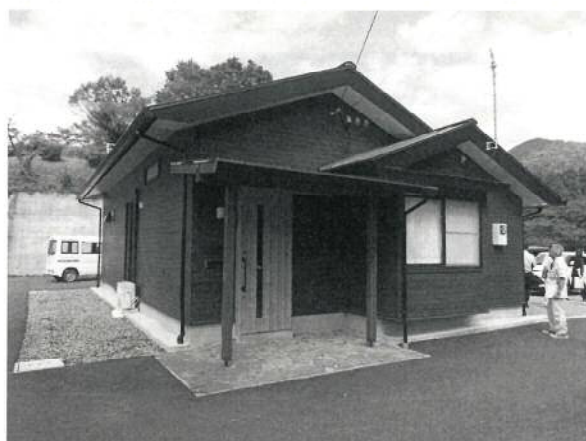
社会資本整備総合交付金事業 空き家活用改修工事 (広木野)
