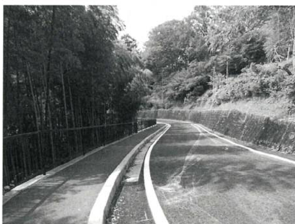
社会資本整備交付金事業 災害防除工事 歩道改良工事 (赤谷・小学校線)
