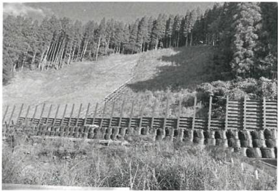
対象となる地滑り現場
