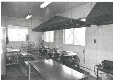
親子方式へ改修予定の三小給食室
