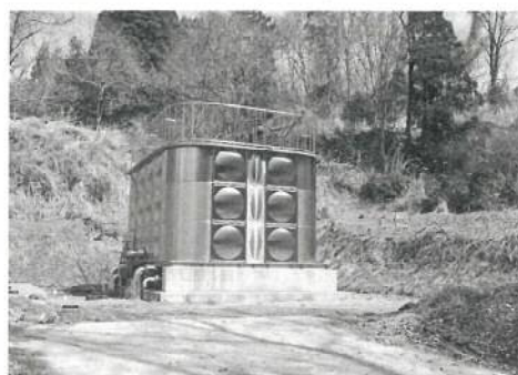
整備中の兼ヶ瀬水道施設
