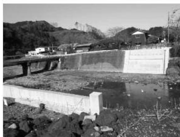
貫原橋の橋梁工事
