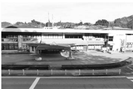
建設基本計画が進む役場庁舎
