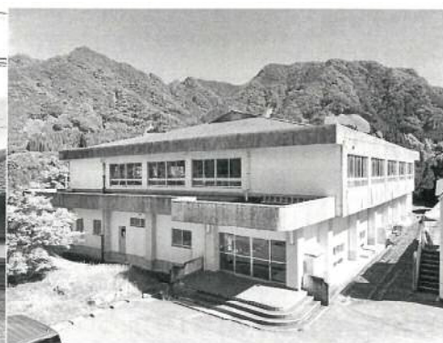
雨漏り補修予定の鞍岡小体育館
