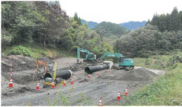
▲五ヶ瀬西IC（仮称）付近の工事の様子。
